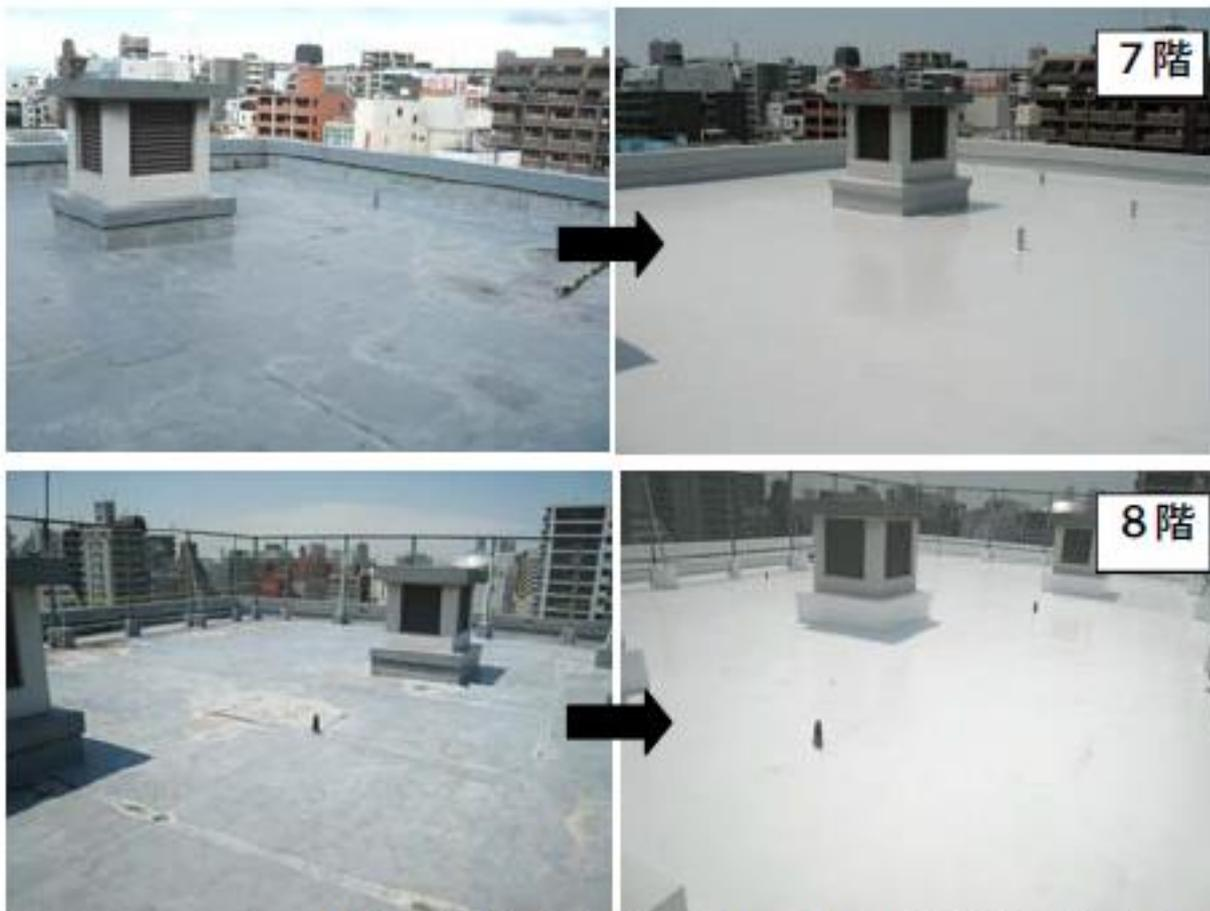
写真1 高日射反射率塗料による防水保護塗装改修
