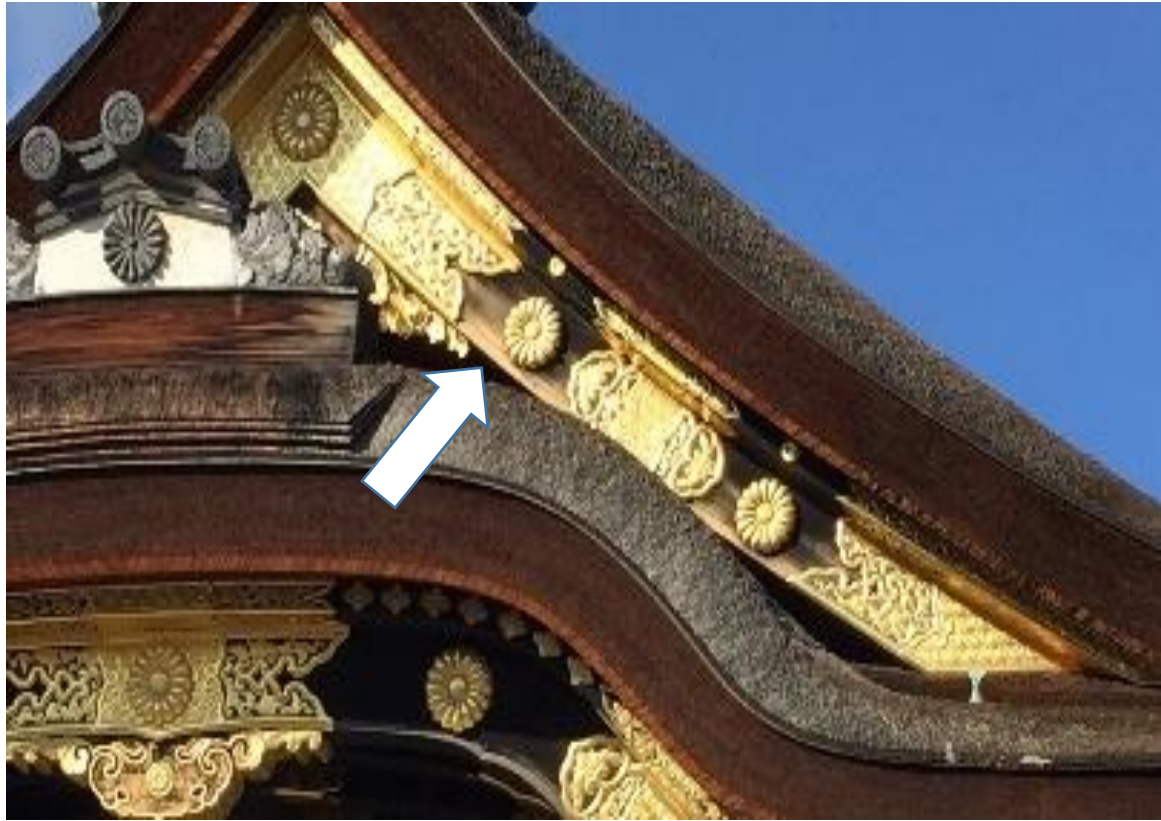
図5 漆膜の屋外劣化の様子
